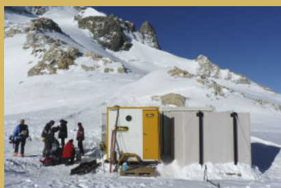
Chantier au refuge de l'aigle ©E.Vannard
