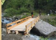
Des efforts conjugués qui permettent d'installer une nouvelle passerelle de 1,50 m de large... qui reste démontable pour l'hiver. En cas de crue majeure pendant l'été, elle est retenue par un câble et doit venir se déposer sur la berge. Et ce, malgré ses 700 kg et ses 7,6 mètres de portée.
