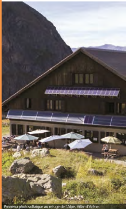
Panneau photovoltaïque au refuge de l'Alpe, Villar-d'Arène.
