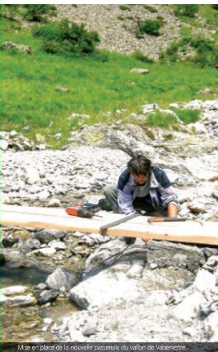
Mise en place de la nouvelle passerelle du vallon de Valsenestre.
