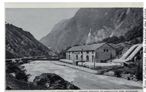
> Usine hydro-électrique des Roberts (Oisans)
