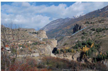
> Conduite forcée (Vallouise)
