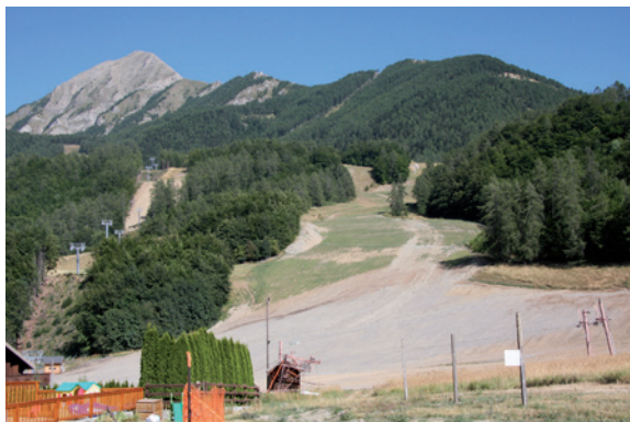
> Remontée mécanique et piste de ski alpin, station de Saint-Léger les Mélèzes
