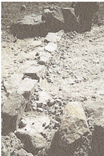
rigole maçonnée en pierres sur chant
