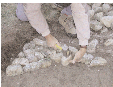
pose et blocage
