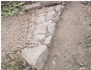
revers d'eau maçonné
