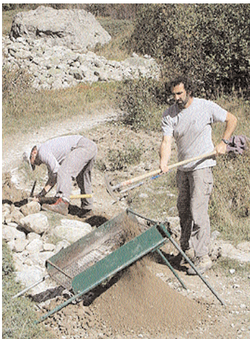
grille de criblage
