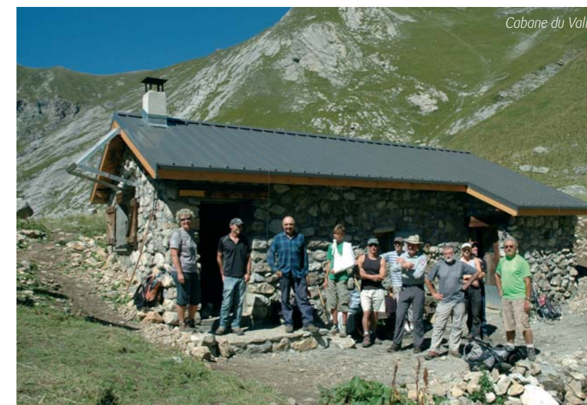
Restauration des murets au Saut du Laire
