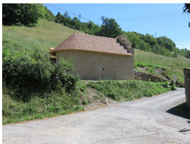
et APRÈS travaux
