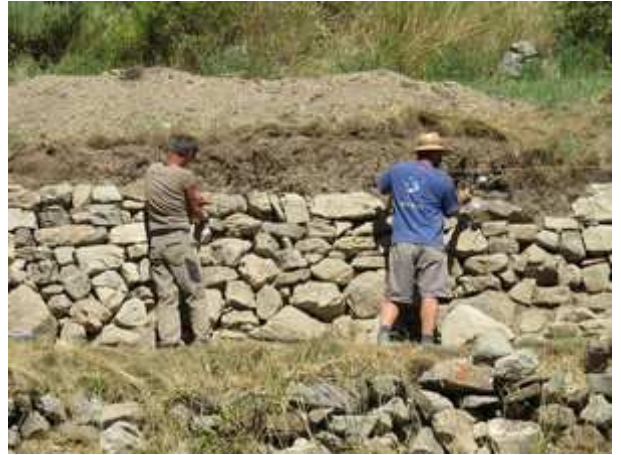
Restauration d'un mur de pierre sèche, Réallon
