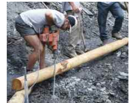
Soutènement en gabion bois Malafosse - vallon du Fournel
