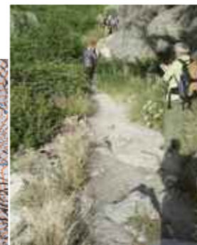
E1 : passage en bord de torrent en surplomb - éboulement par sappe du torrent ouvrage de soutènement à construire
