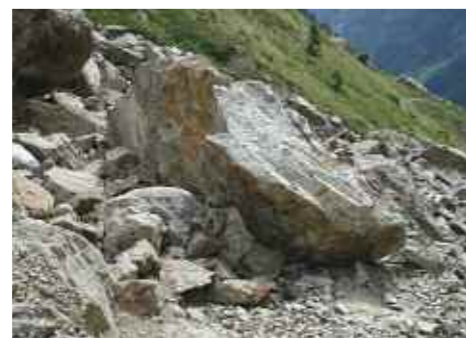
E7 : chute de bloc récente - sentier à recréer avec emmarchement sur 15 m
