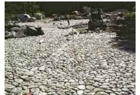
Au Pré de Mme Carle, l’aire d’accueil des visiteurs, empierrée sur 2000 m 2 avec des galets du torrent liés par un mortier de chaux.
