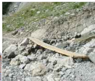
E6 : Franchissement du Torrent du Clot de l’homme. Passage difficile à tenir - envisager un déplacement
