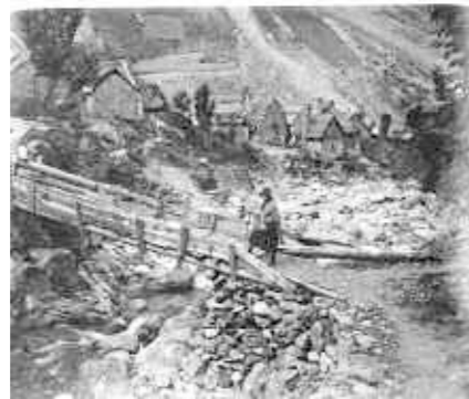
Accéder au hameau de Navette, dans le Valgaudemar, fut longtemps une nécessité
