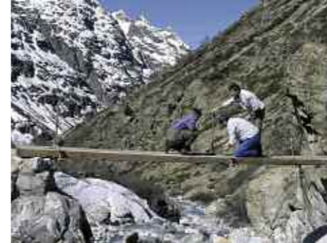
La passerelle de Bonnepierre
