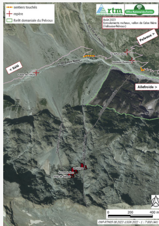
Figure 10: Photo aérienne de la zone d'impact et de la trajectoire de l'éroulement rocheux en rive gauche du couloir Pelas-Verney. ONF-RTM 05
