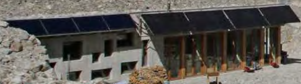
Refuge du Pavé, derniers travaux et inauguration le 27 août 2024
