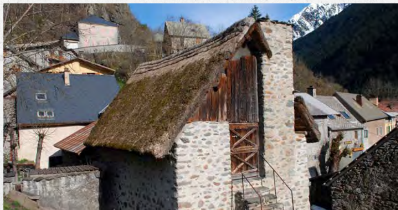
Le moulin de Villar-Loubière
