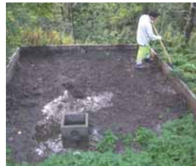
Exutoire des eaux traitées à Dormillouse
