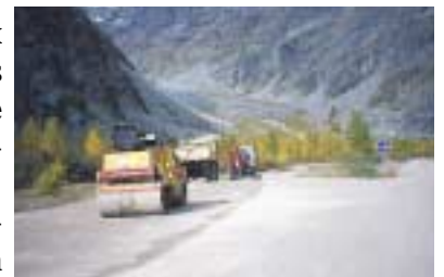
Des travaux pour un parking de printemps à l'entrée du Pré de Mme Carle.
