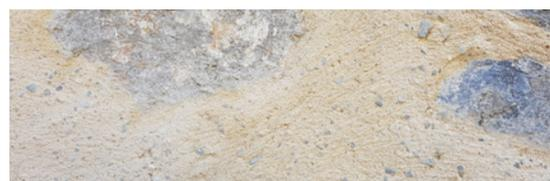
Détail de la finition du four, béton de chaux brossé
