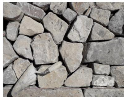
Principe d'assemblage d'une calade
