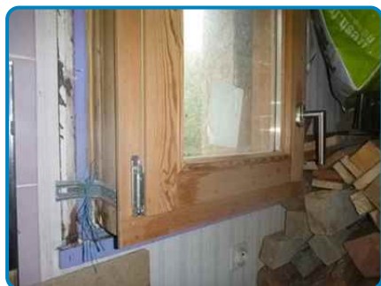
Menuiseries très récentes
