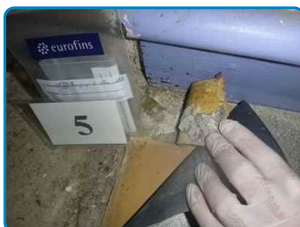
Prélèvement n° 5 : Plancher Ragrée et colle (dans 1er étage Salle de bains)
