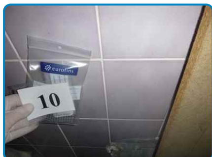
Prélèvement n° 10 : Mur Joint de faïence murale (dans 1er étage Salle de bains)
