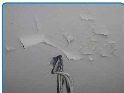
Enduit de plâtre en plafond
