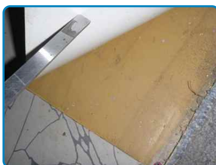
Revêtement plastique en lé orange en couche inférieure de plancher de l'entrée
