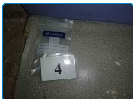
Prélèvement n° 4 : Plancher couche supérieure Revêtement plastique en lé et colle (dans 1er étage Salle de bains)
