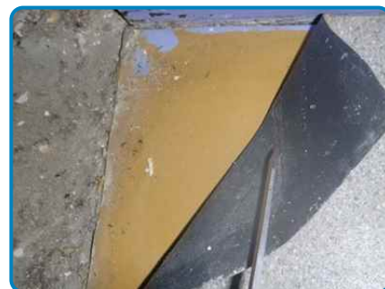
Revêtement plastique en lé orange en couche inférieure de plancher salle de bains
