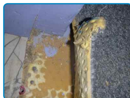
Revêtement plastique en lé orange en couche inférieure de plancher du séjour
