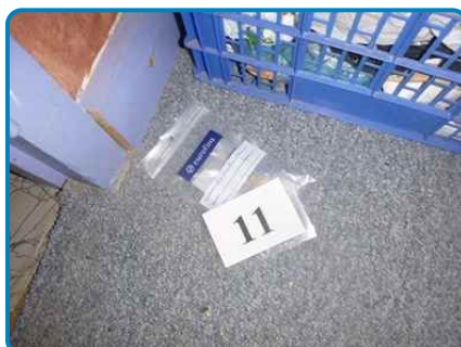
Prélèvement n° 11 : Plancher couche supérieure Moquette (dans 1er étage Séjour)
