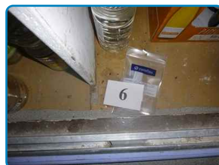
Prélèvement n° 6 : Plancher Revêtement plastique en lé orange et colle (dans 1er étage Placard sdb)
