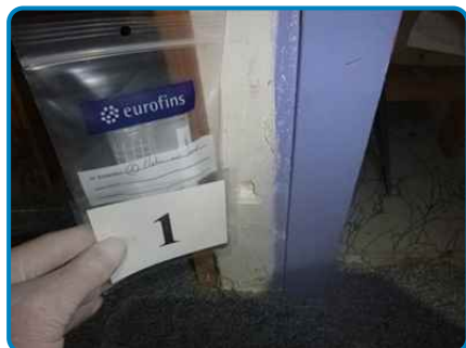
Prélèvement n° 1 : Mur Plâtre (dans 1er étage Coin cuisine)
