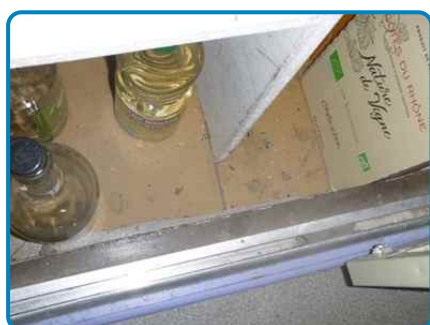
Revêtement plastique en lé orange en plancher placard salle de bains
